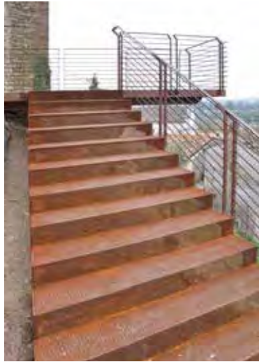
12-16. Ponti sul Mincio (MN), restauro del Castello Scaligero, in corso: vedute e pianta del percorso di accesso con la scala in corten, dettaglio costruttivo della scala e particolare del cancello (foto: Marcello Righetti).
