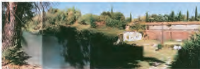
▼ Il bastione assurgente di San Francesco (1836 - 38) dissolto dalla vegetazione. Sono iniziati i lavori di disadamento
