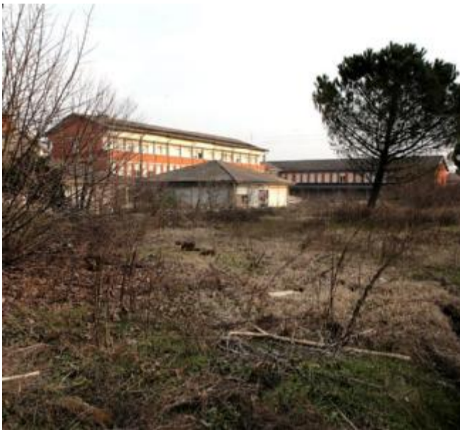
Edifici abbandonati nell'ex area Monfortani ad Arbizzano
